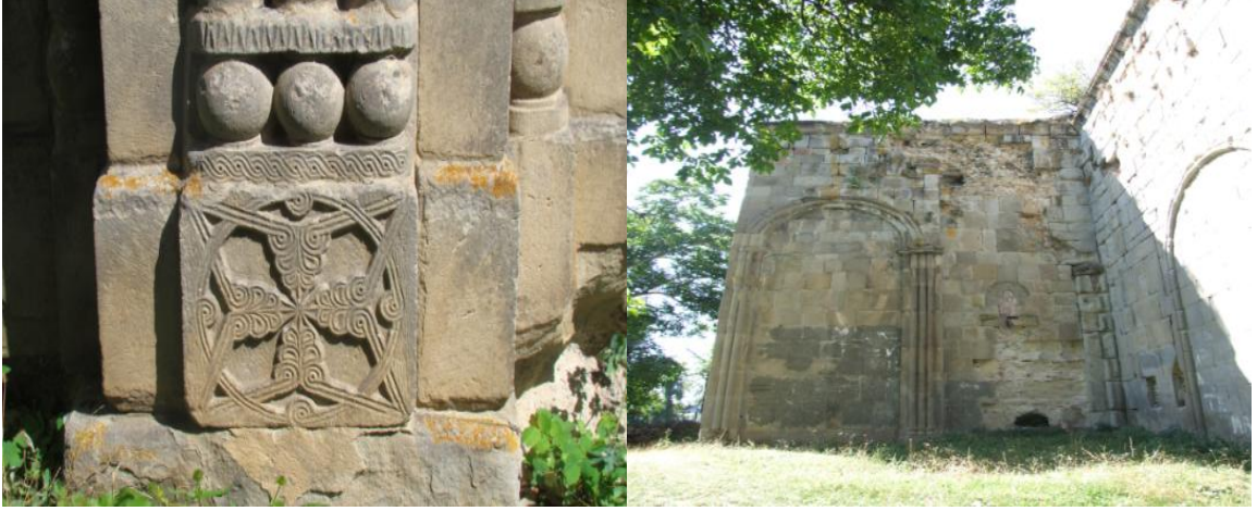
Resim 39: Cevizli (Tbeti) Manastır Kilisesi, güney haç kolu cephesi, doğu arkad sütunçe kaidesi-3.
