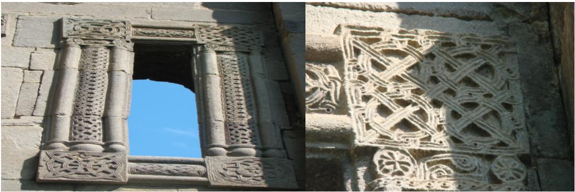
Resim 25: Cevizli (Tbeti) Manastır Kilisesi, güney haç kolu cephesi, orta arkad doğu penceresi.
