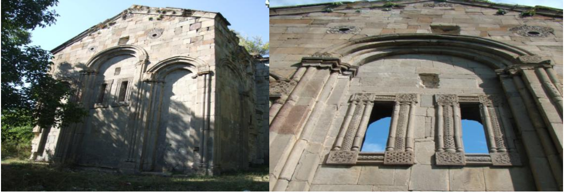
Resim 21: Cevizli (Tbeti) Manastır Kilisesi, güney haç kolu cephesi.
