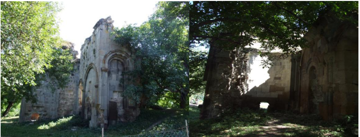
Resim 43: Cevizli (Tbeti) Manastır Kilisesi, kuzey batıdan görünüm.
